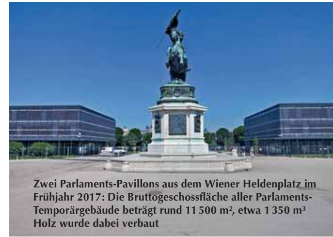
Ein Pavillon des „Temporären Parlaments“ wird im Wiener Bibliothekshof im System Lukas Lang errichtet. Nach der temporären Nutzung und Abbau erfolgen erneute Einsätze als Kindergarten, Schulen oder ähnlichem – immer wieder, in unterschiedlicher Dauer
