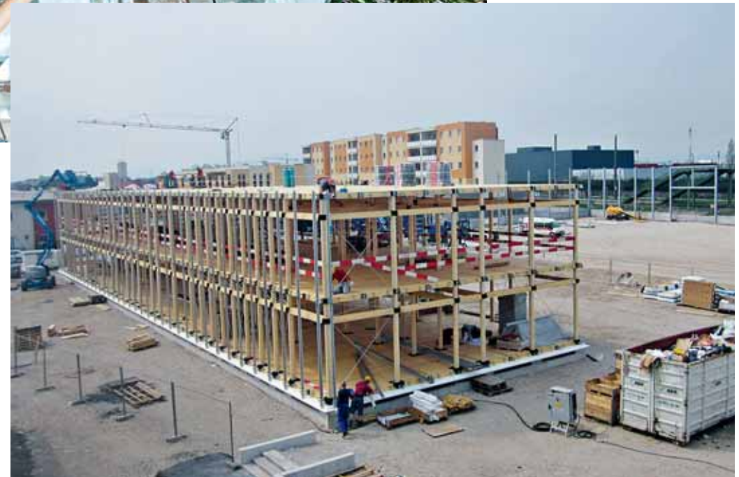
Unten: Die österreichische Firma Lukas Lang Building Technologies steht für mobile Holzbauweise nach einem selbstentwickelten Baukastensystem: hier beim Rohbau der Strabag-Verwaltung Schleppbahngasse in Wien Neustadt (Fotos: Lukas Lang, Grotefeld/Maitra)
