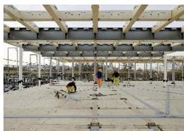
gfnd1803\_b1: Bereits vor Baubeginn muss im Holzbau bei jedem einzelnen Element jede Bohrung exakt „sitzen“. Während der Aufbauphase ist sind „Nachbesserungen“ beinahe ausgeschlossen.
